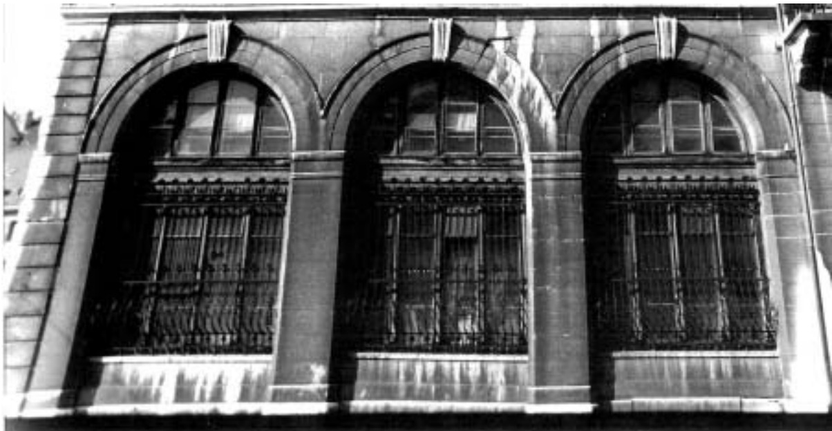
Hautes baies en plein cintre, face sud
