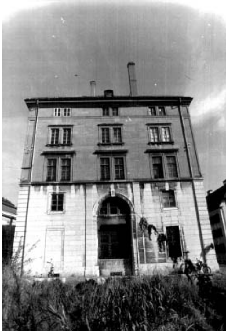
Ancienne poste, face ouest
