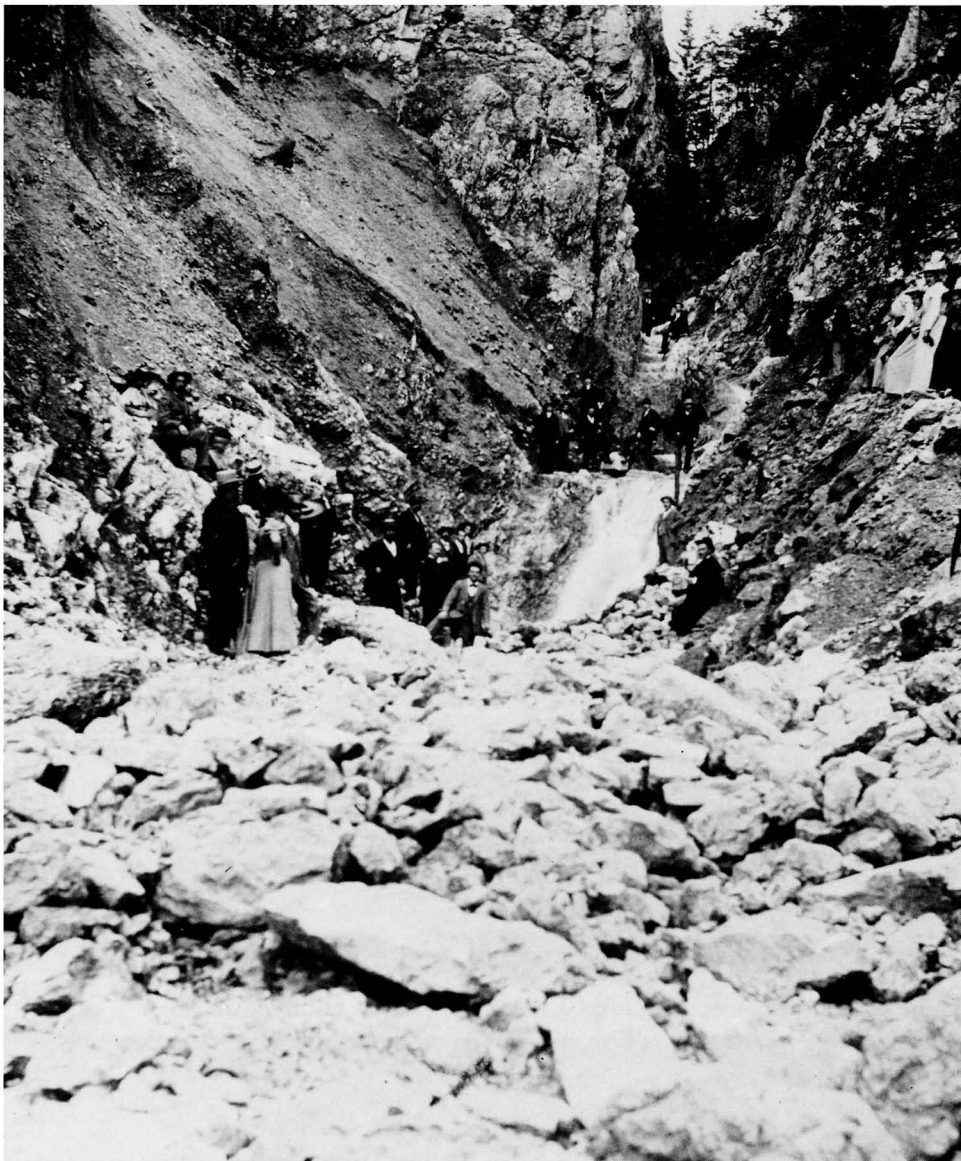
L'érosion procède par bonds: conséquences d'une crue violente du torrent des Entre deux Monts dans «les Chaudières» de la Baume (1896?). Des blocs volumineux arrachés aux éboulis des versants forment une imposante accumulation au bas de la cascade. Une image qui n'est pas sans analogie avec celle du Col des Roches (gravure, p. 109).
