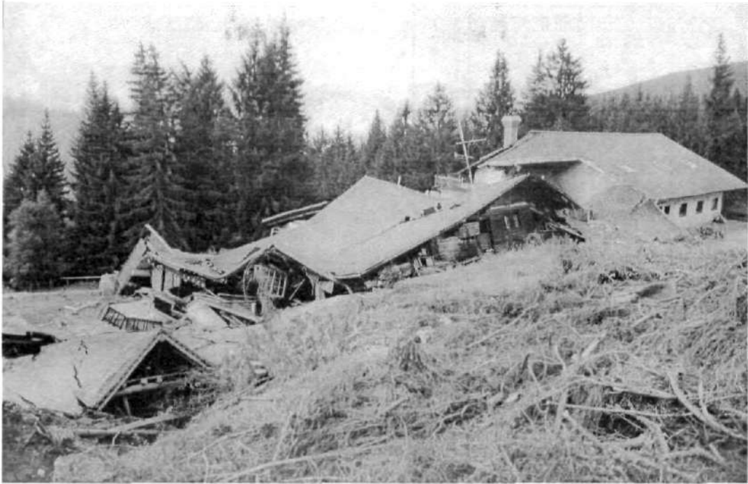
Abbildung 6.6: Blick auf die zerstörte Ferienhaussiedlung (H. Raetzo, Pers. Kommunik.)
