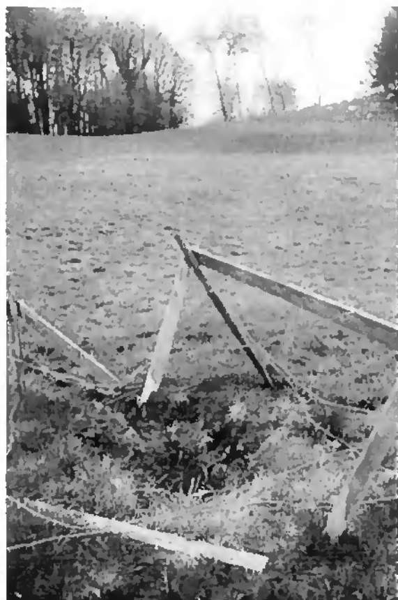
Abbildung 5.16: Einbruch in der Doline des künstlichen Eingangs (P6) zur Grotte Milandre
