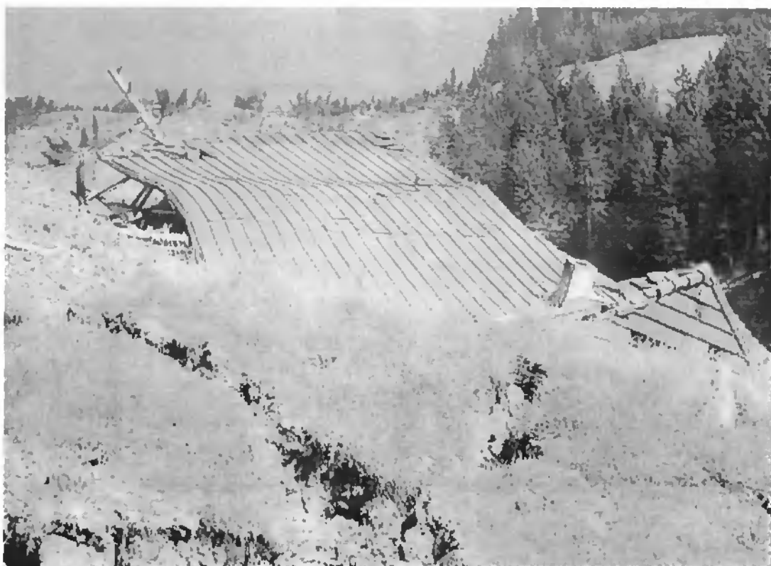
Abbildung 6.5: Erdbewegungen mit Grabenbildung in Nähe der Anrißkante (H. Raetzo, Pers. Kommunikation.)
