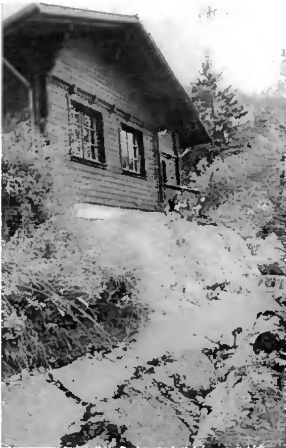
Abbildung 6.4: Schäden durch die Rutschung (H. Raetzo, Pers. Kommunik.)
