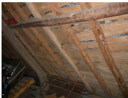
Figure 17 : ferme de forme courbe à sa base. Les chevrons sont en frêne, sauf le plus clair qui est en tilleul
