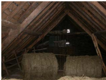
Figure 17 : ferme de forme courbe à sa base. Les chevrons sont en frêne, sauf le plus clair qui est en tilleul
