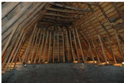
Figure 19 : charpente « tout bois » de la chapelle d'Ortiac rénovée en 1961. Elle est construite sans ferme
