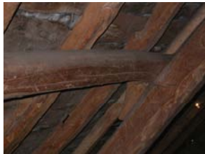
Figure 12 : échantignolle entre l'arbalétrier et la panne
