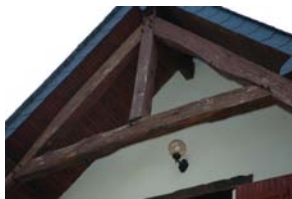
Figure 13 : poinçon entre l'entrait et le faîtage
