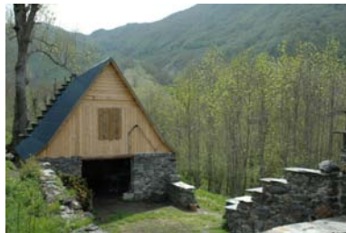
Figure 15 : grange rénovée où l'on a gardé la forme ancienne
