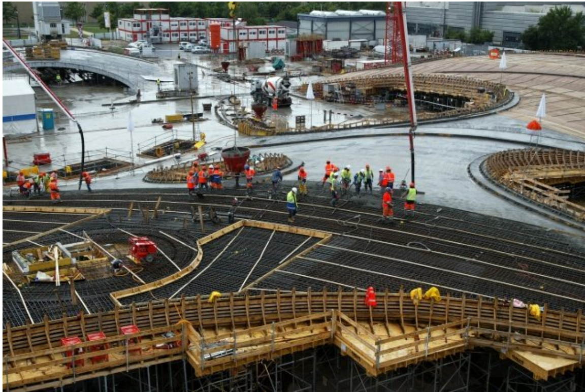
Figure 8 : Bétonnage de la coque principale du Learning Center (Photo : Alain Herzog / EPFL / juillet 2008 © droits réservés)
