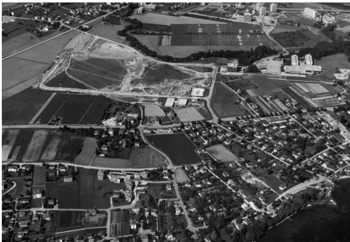
Figure 7 : Vue aérienne du chantier du campus EPFL et de ses alentours en 1974 (Photo : Germond / EPFL © droits réservés)
