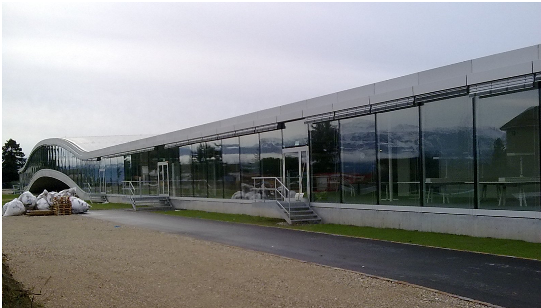
Figure 6 : Chantier du Learning Center en décembre 2009 – façade nord (Photo : MS)
