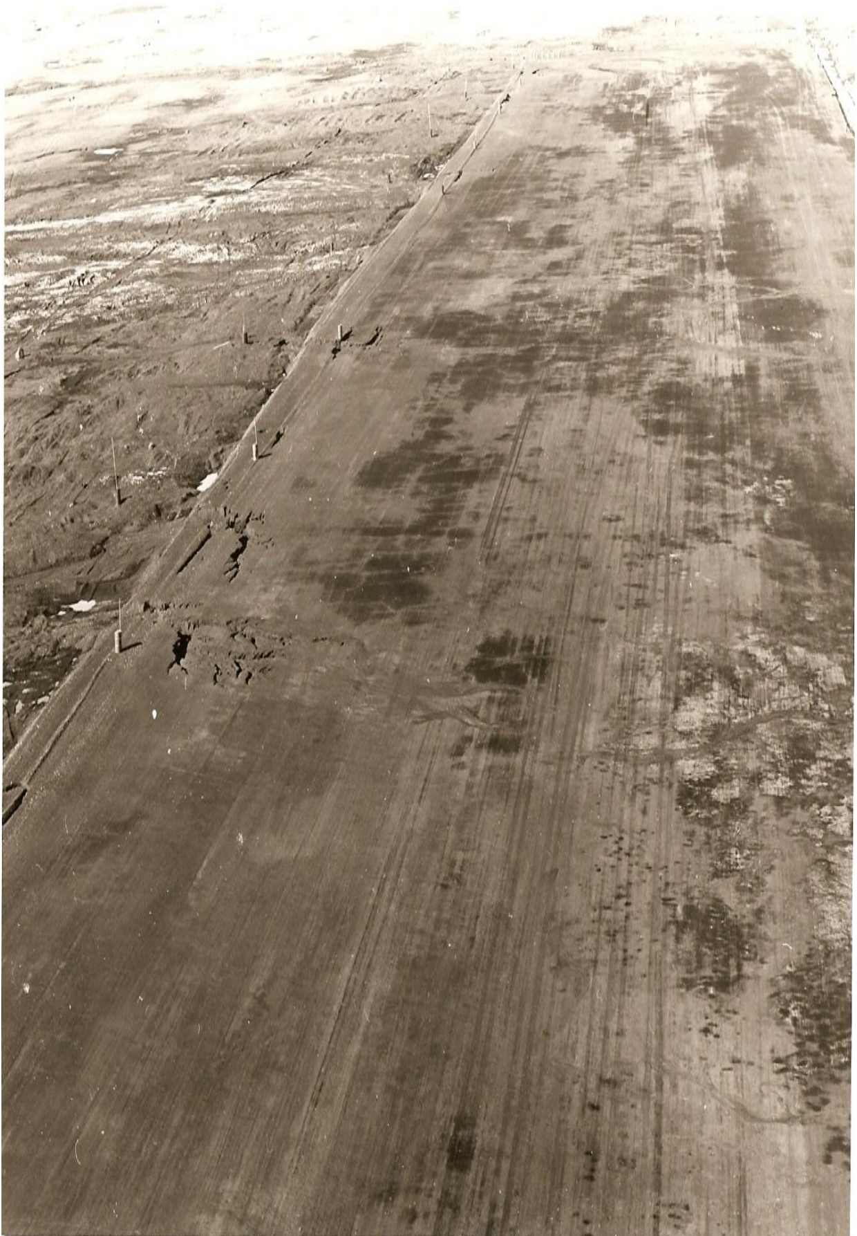
Abbildung 12: Die Piste bei der Station Nord, Blickrichtung Nord. Gut erkennbar sind für uns die während des Sommers reperaturintensiven Erosionsstellen am westlichen Pistenrand und die Markierungsfässer. Aufgenommen während der Rekognoszierung zur Wiedereröffnung der Station Nord am 7.8.1974. Foto aus Privataarchiv Gunnar Jensen.
