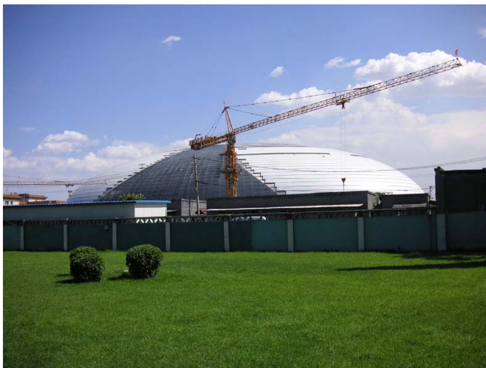
Fig. 2.6 Le chantier de l'Opéra
