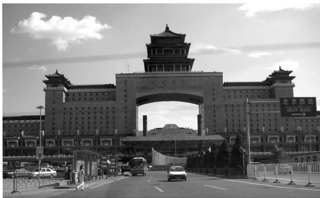
Fig. 2.7 L'architecture nationaliste de la gare de Beijing-Ouest
