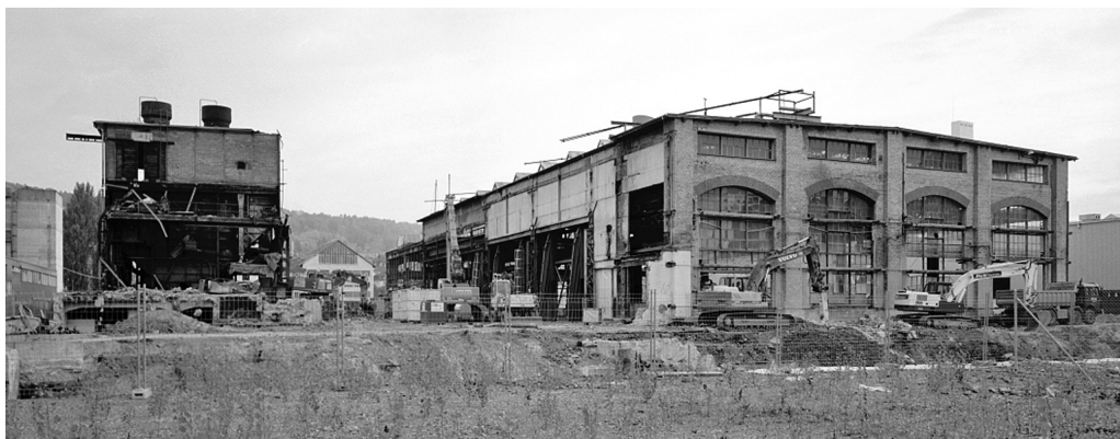
Photo 1. Début des travaux sur l'ancienne fonderie de Sulzer-Escher-Wyss à Zurich West (Photo : Amt für Städtebau, Zürich).
