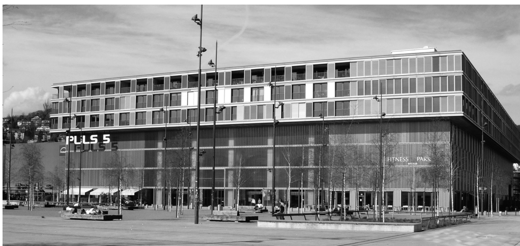
Photo 2. Construit sur le site de l'ancienne fonderie de Sulzer-Escher-Wyss, le Puls 5 à Zurich West comprend des activités économiques ainsi qu'une centaine d'appartements aux trois derniers étages. Au premier plan, un nouvel espace public : la Turbinenplatz (Photo : P. Rérat, 2007).
