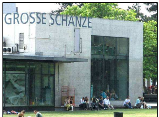
19 Détournement de la plateforme derrière l'ascenseur, GS (JL 11.06.2008)
