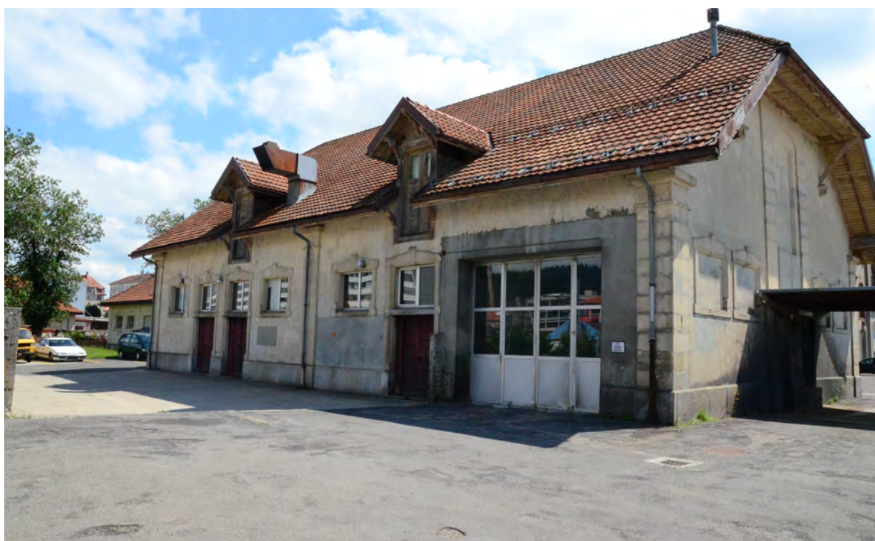
Figure 30 : Ancienne bouverie, aujourd'hui salle de réunion et garage (source personnelle)
