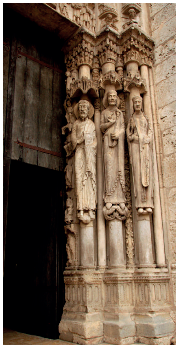
Fig. 70: Chartres, cathédrale, façade occidentale, portail de droite, ébrasement de droite, statues-colonnes.
