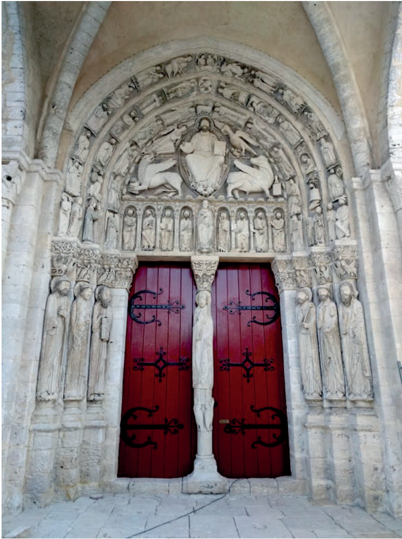
Fig. 57 : Saint-Loup-de-Naud, église paroissiale, portail occidental, état après la restauration de 2017.
