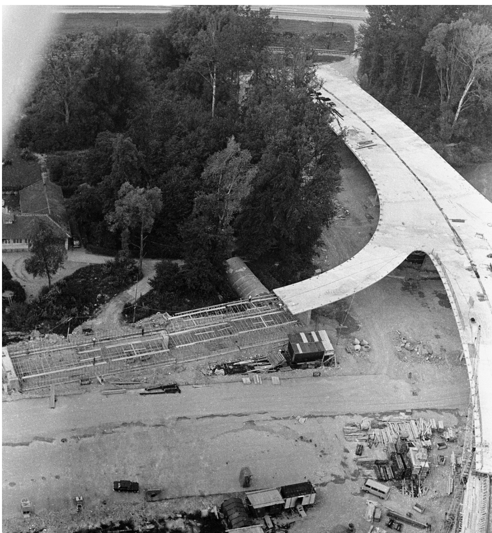
A l'intérieur du pont de l'autoroute N5 en construction, dans le bosquet, se trouve le gisement de La Saunerie. Au centre de l'image, on peut voir la tente qui abrite la fouille menée par Boisaubert en 1972-1975. Cliché : OPAN.
