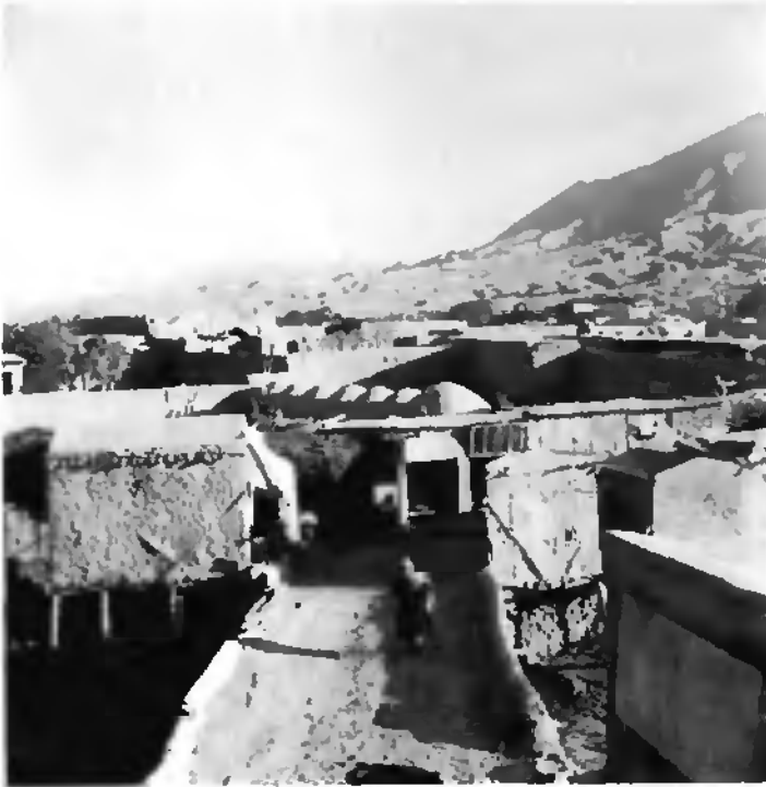
e) pont de brique et route de Q.
