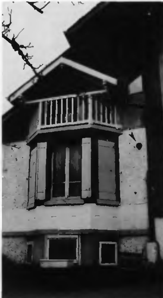
Fig. 37 : Tuyau d'un déversoir à purin qui a servi de nid à un couple de Chevêches à Lully (FR). La flèche indique l'entrée de la cavité.
