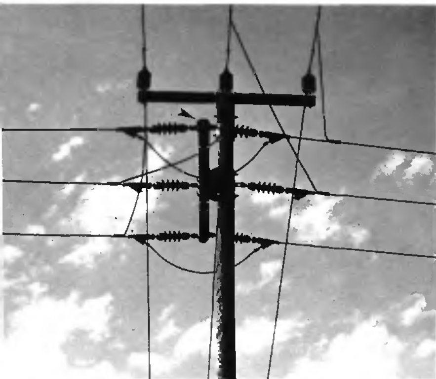
Fig. 39: Pylône électrique dans lequel la Chevéche a niché avec succès en 1976 à Lully (GE). La flèche indique l'entrée de la cavité.
