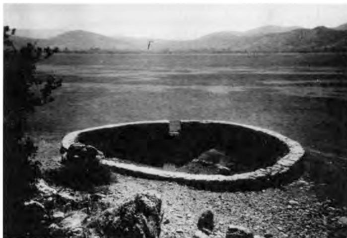
b. Lac Takka, système de protection actuel d'un des émissaires d'évacuation à Kukujeros (d'ap. Knauss, 1988, fig. 3).
