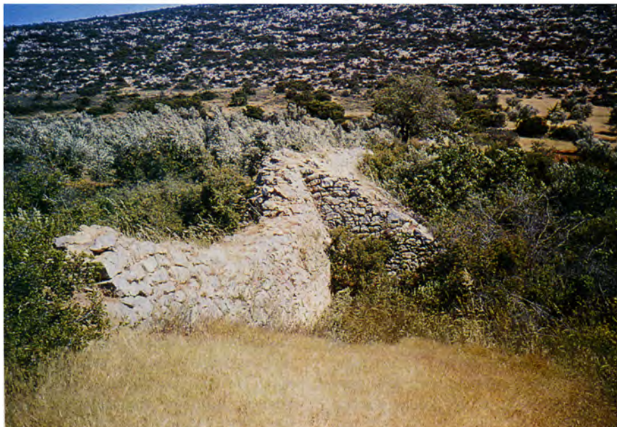
Thisbé, petite digue, avec le mur de réparation byzantin (d'ap. Knauss, 1989 b, fig. 18).
