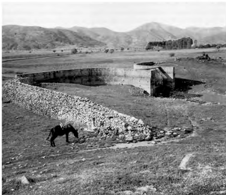
a. Plaine de Kandila, dispositif de protection actuel de la catavothre (d'ap. Knauss et al., 1986, fig. 7).
