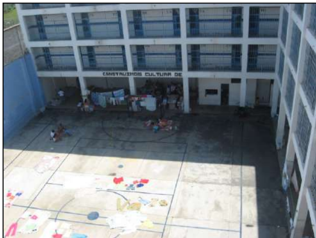
Photographie III.5. Quartier des femmes à la prison de haute sécurité de Valledupar. Source : FCSP.
