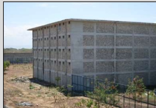
Photographie II.11. Bloc d'hébergement, prison de haute sécurité de Valledupar (Colombie). Source : FCSPP (2010)
