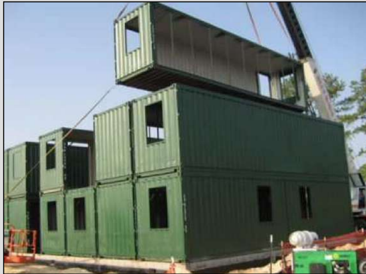
Figure II.6. Les containers ISBU, matériau de construction de la prison instantanée. Source : Carter (2011).
