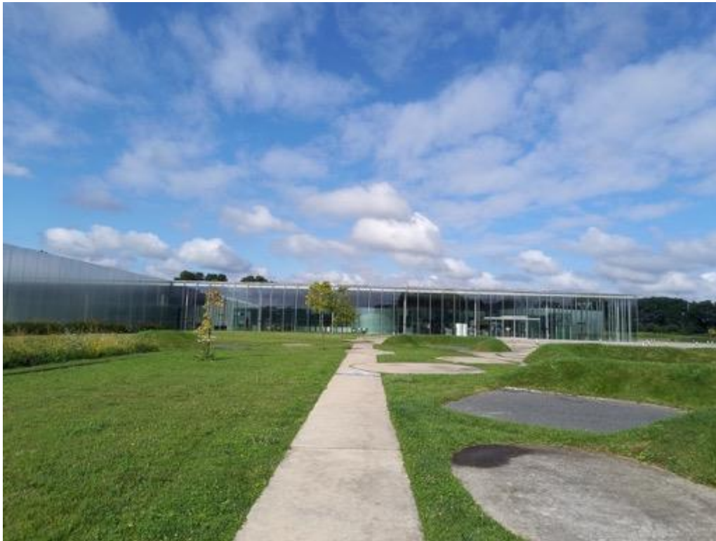
En direction du hall d'accueil, vis-à-vis avec sa façade vitrée Est.
