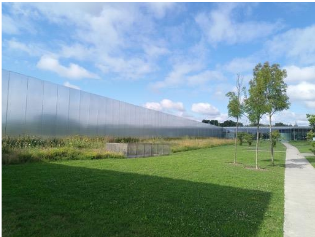
La façade en aluminium anodisé de la Galerie du temps.
