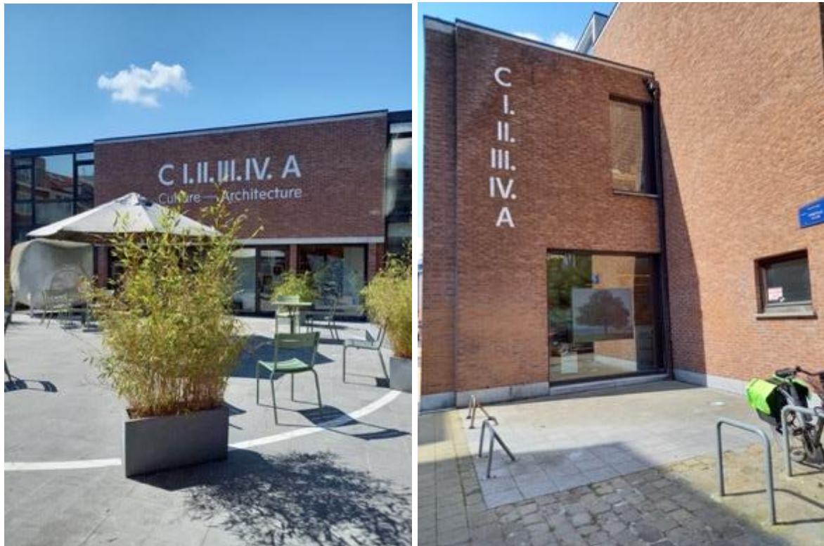
Vues extérieures du bâtiment du CIVA à Ixelles.
