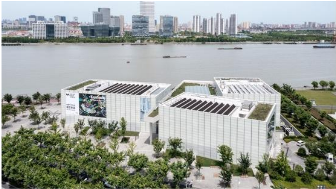
Illustration 31 : Vues extérieures de l'architecture du West Bund Museum
