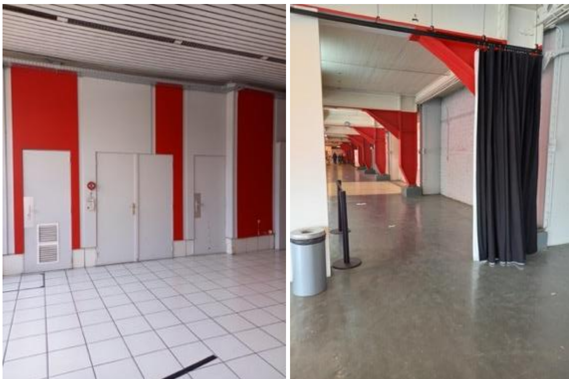
Photo 45 : Code couleur Citroën au sein du bâtiment
