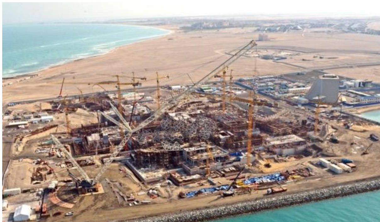
Illustration 29 : Le chantier du Louvre Abu Dhabi sur l'île de Saadiyat
