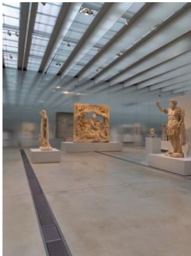
Photo 26 : Grilles traversantes de la Galerie du temps
