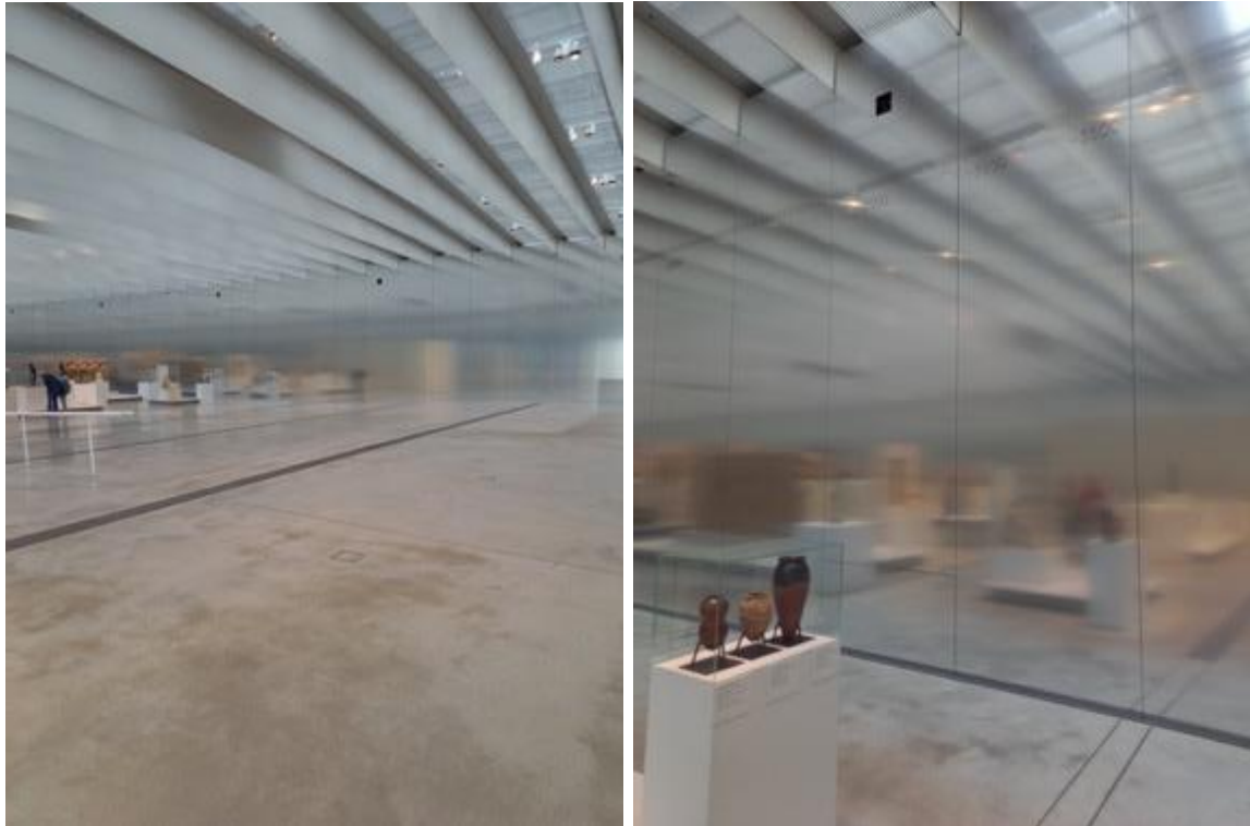
Photo 21 : La surface miroitante des parois en aluminium anodisé
