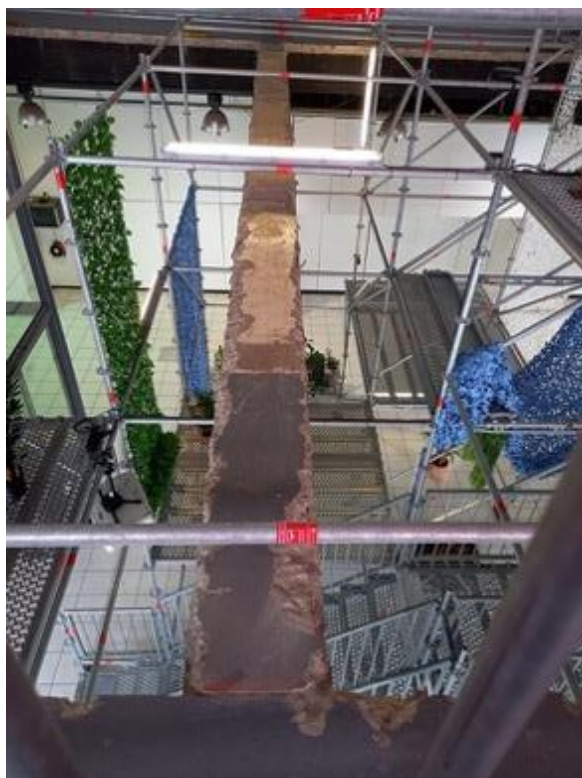
Vue de la découpe du plateau en béton, poutrelle de maintien et structure de l'installation sous forme d'échafaudage. Cage d'ascenseur entre le rez-de-chaussée et le niveau 1 du showroom.
