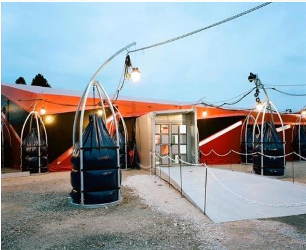
Illustration 8 : Entrée et lestes du Centre Pompidou mobile
