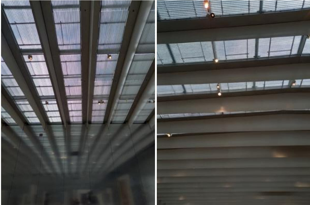
Photo 23 : L'éclairage zénithal et le dispositif de volets
