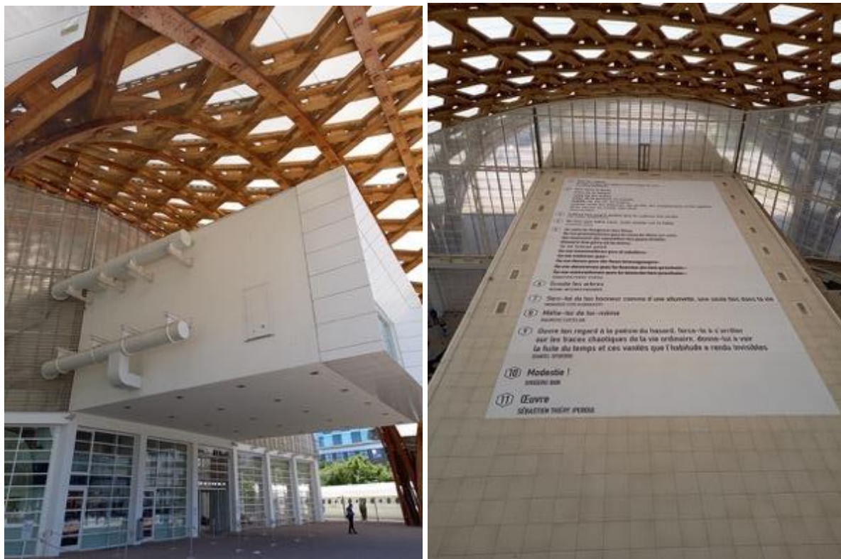
Photo 4 : Les galeries tubes
