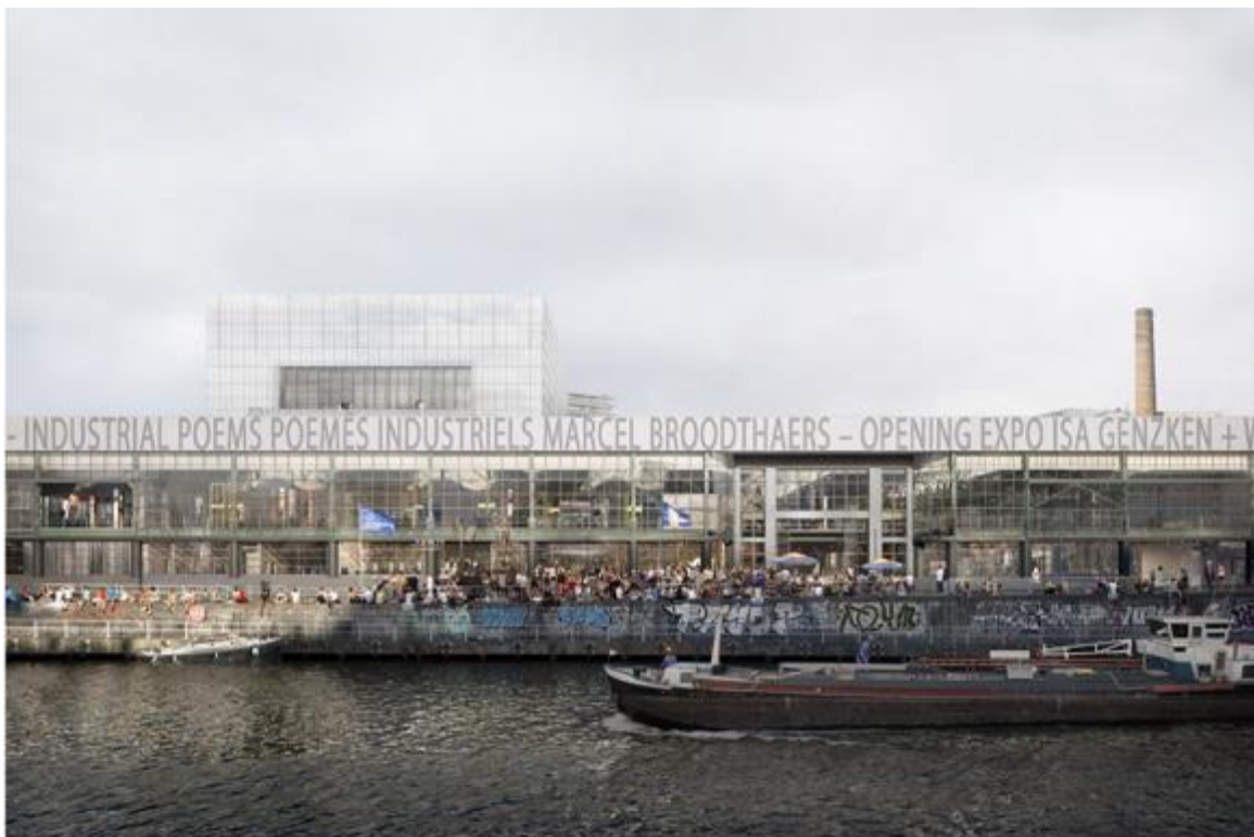
Illustration 25 : Bandeau lumineux programmable en façade
