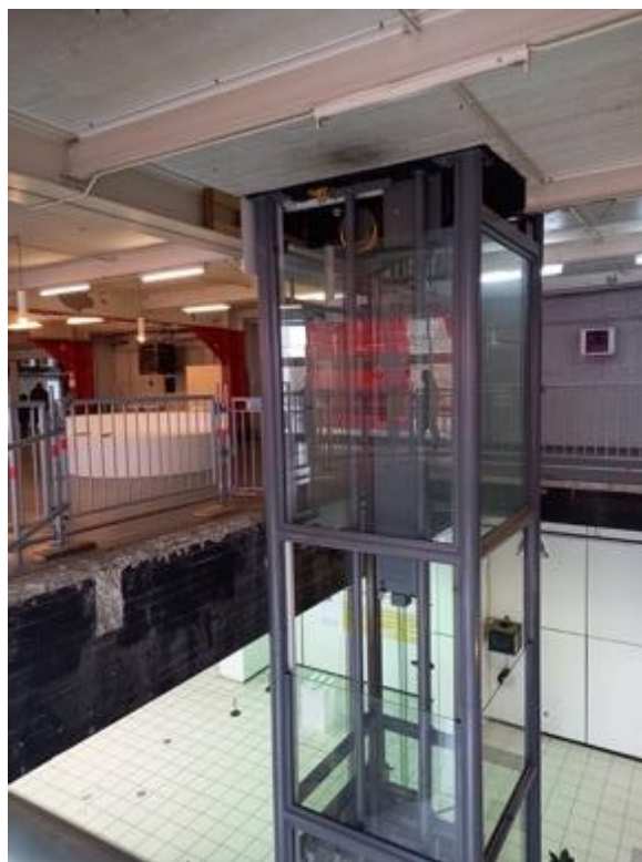
Vue de la découpe du plateau en béton, poutrelle de maintien et structure de l'installation sous forme d'échafaudage. Cage d'ascenseur entre le rez-de-chaussée et le niveau 1 du showroom.
