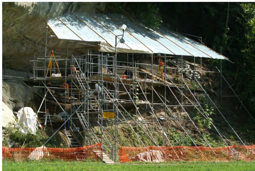
Fig. 21. L'abri d'Arconciel/La Souche en cours de fouilles avec la structure métallique protégeant des intempéries et supportant les espaces surélevés sur lesquels les fouilleurs travaillaient. Photographie : M. Mauvilly, 2007.
