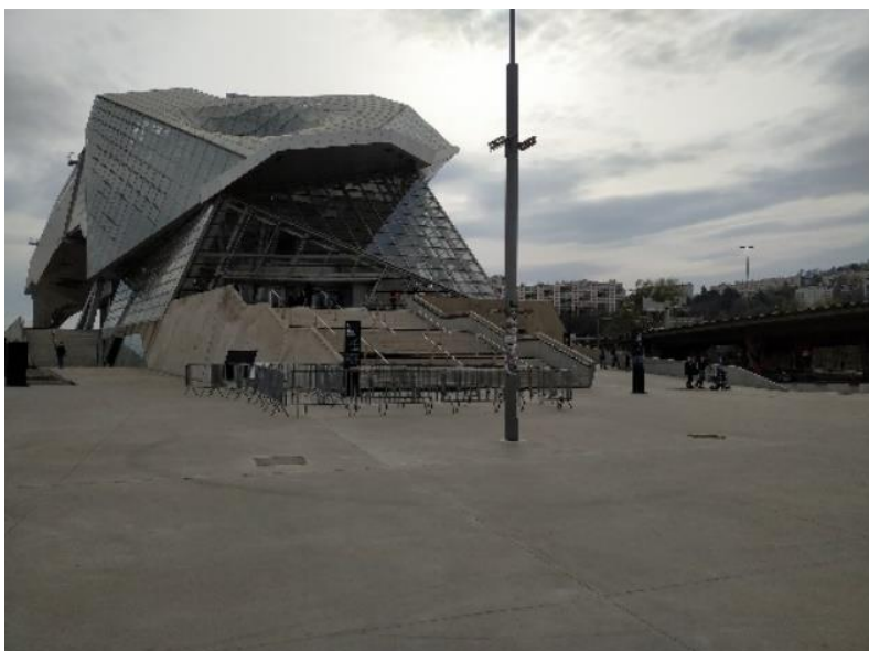
Figure 85 Entrée principale du musée des Confluences. Photographie réalisée par Raphaël Osé
