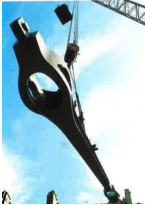
Figure 48 Levage d'une gerberette. Source : Source : PIANO Renzo, RICHARD Rogers, Du Plateau Beaubourg au Centre Georges Pompidou , Paris : Editions du Centre Pompidou, 1987, p. 92.
