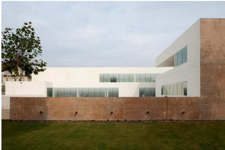
Figure 102 Centre de Conservation et de Ressources de Marseille. Source : https://www.vezzonei-associes.com/architecture/ccr-mucem/
