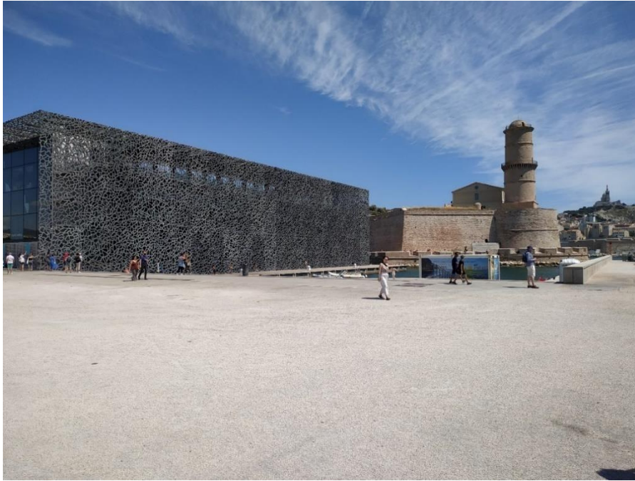
Figure 103 Vue du MuCEM et du fort Saint-Jean depuis l'esplanade du J4. Photographie réalisée par Raphaël Osé
