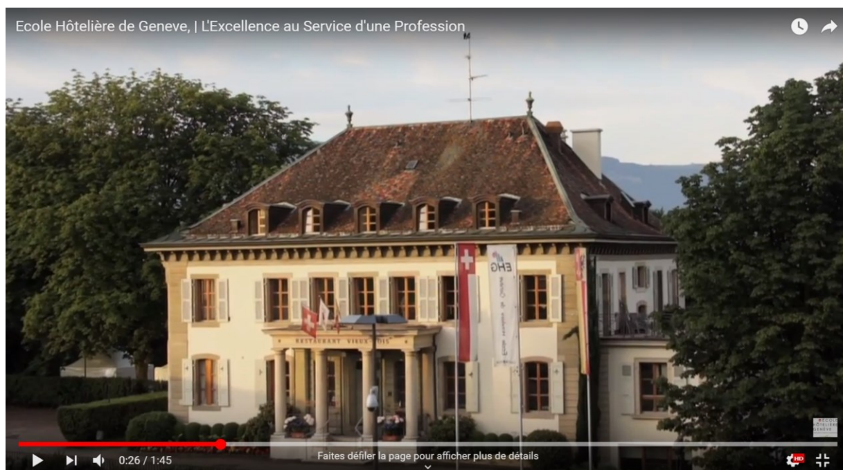
Figure 18 : Bâtiment principal de l'École hôtelière de Genève
