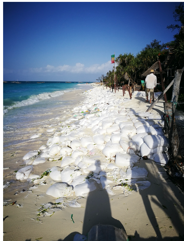
Figure 8. Digues de protection contre la montée des eaux. Nungwi, janvier 2018
