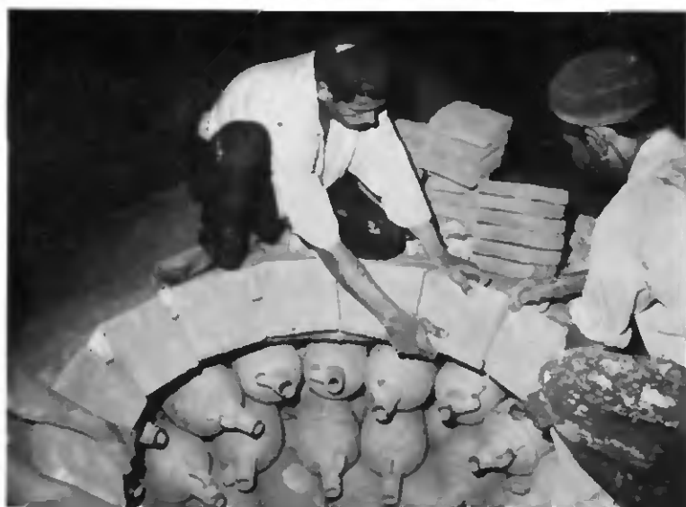
17. Construction de la calotte de fermeture du four au moyen de briques crues.
