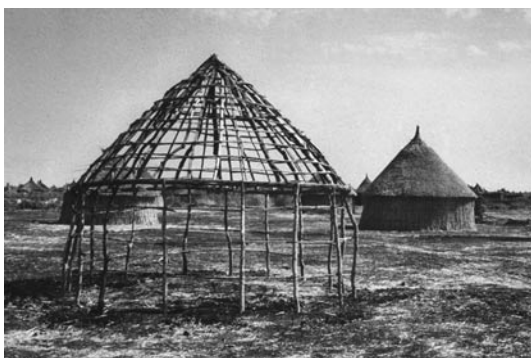
Fig. 8 Construction d'une hutte sur armature de poteaux de bois, sud du Soudan (photo J.-B. Sevette).
