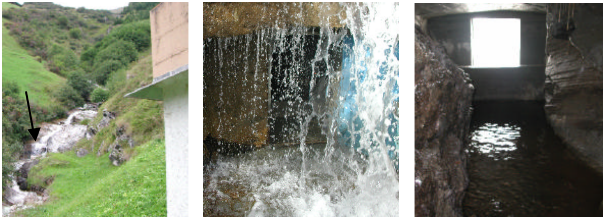
Abb. 63: Quelle Leis: Reservoir mit Blick auf Leisbach, wo die Eingangstüre zur Kaverne (Pfeil) liegt (links). Eingangstüre im Leisbach zur Kaverne (Mitte). Blick vom Quellaufstoss in der Kaverne nach aussen (rechts)
