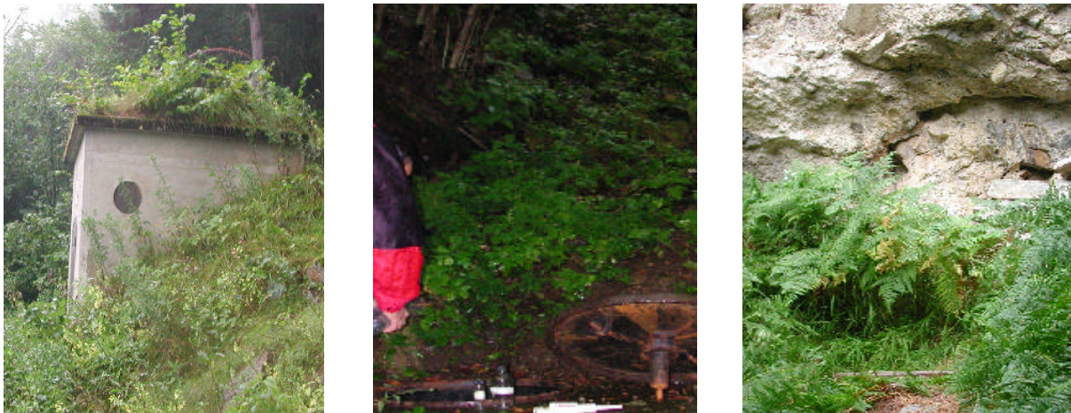
Abb. 73: Quellen in Pagnoncini: Reservoir Pagnoncini (links), Quelle Al Bait (Mitte) und Quelle Sass da Li Rondolli (rechts)
