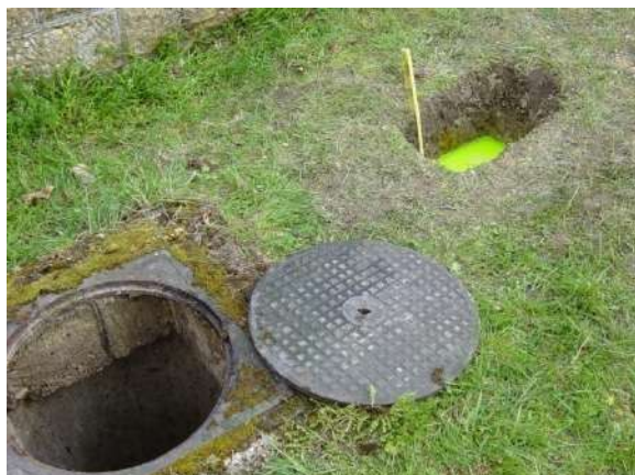
b) Injection d'uranine dans la fouille IEC2. Le caniveau ICC est visible à gauche sur la photo
