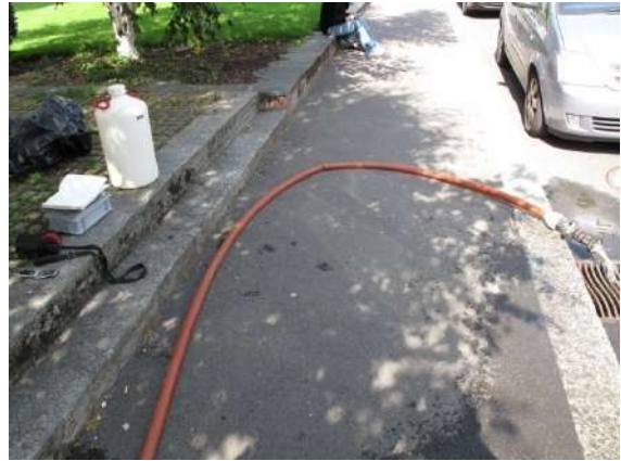
c) Injection de la sulforhodamine G et du naphthionate de sodium dans le caniveau ICN
