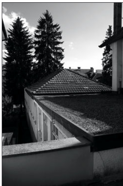
Façade ouest du bâtiment
