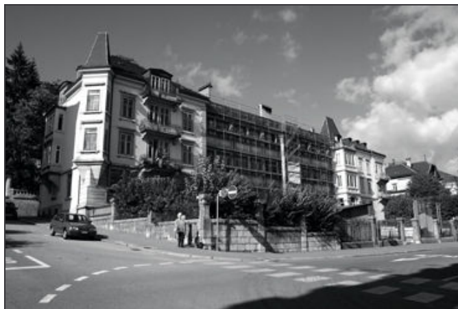
Bâtiment en rénovation inscrit dans un massif
