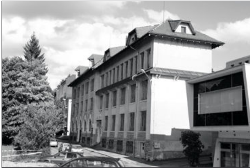
Façades nord et ouest du bâtiment
