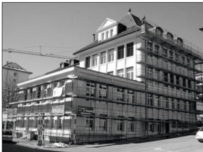
Façades sud et est du bâtiment
