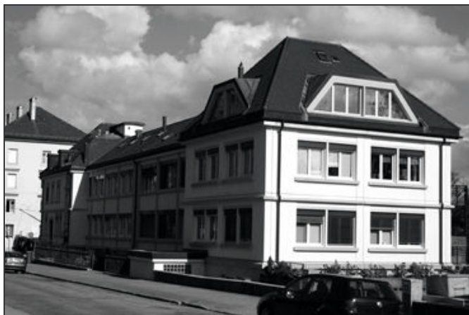
Façades nord et ouest du bâtiment
