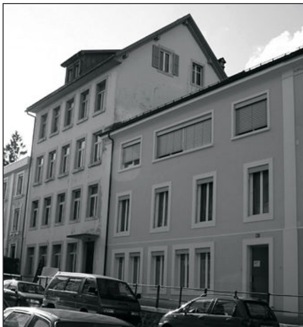
Façade sud du bâtiment
