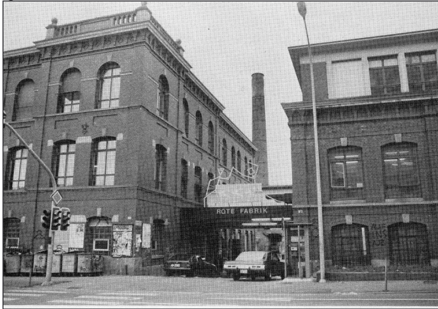
Figure 1 : Rote Fabrik, Zürich
