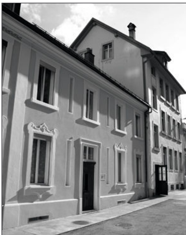
Cliché pris depuis la cour située au sud du bâtiment
