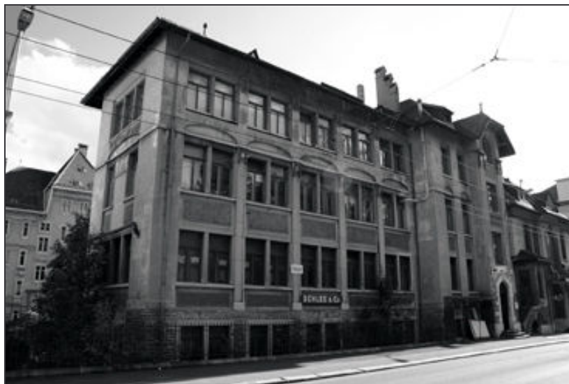
Façade nord (donnant sur la rue Numa-Droz)
