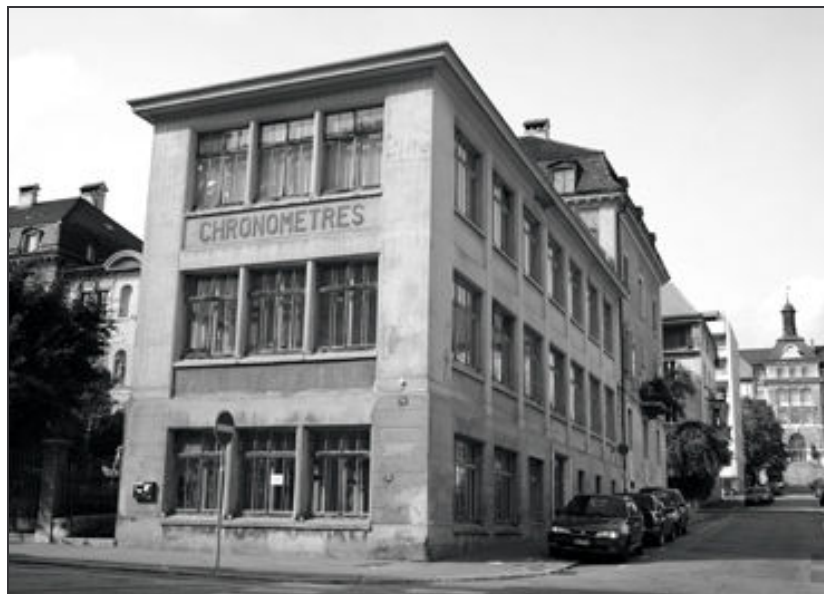
Partie sud du bâtiment. Le premier niveau abrite désormais une garderie d'enfants, le second une usine de sertissage et le troisième, une église.
