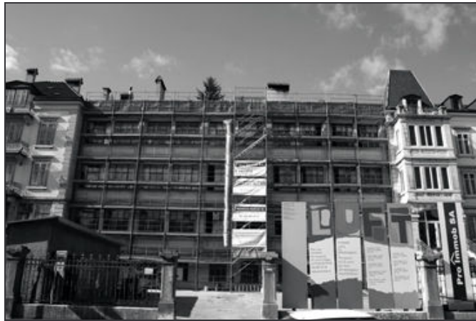
Façade sud du bâtiment
