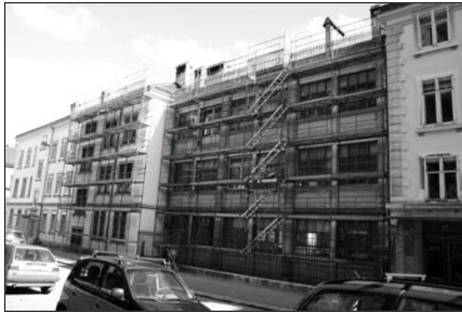
Façade nord du bâtiment
