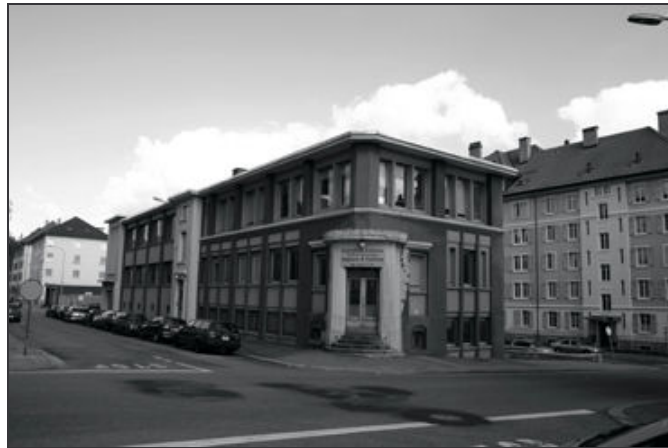
Façades nord et ouest
