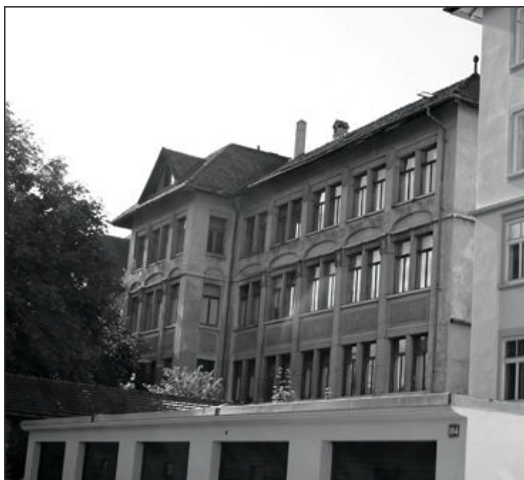
Façade sud (donnant sur la rue de la Paix)
