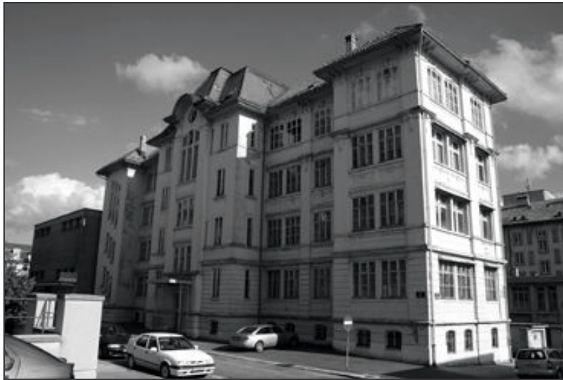
Façades nord et ouest du bâtiment
