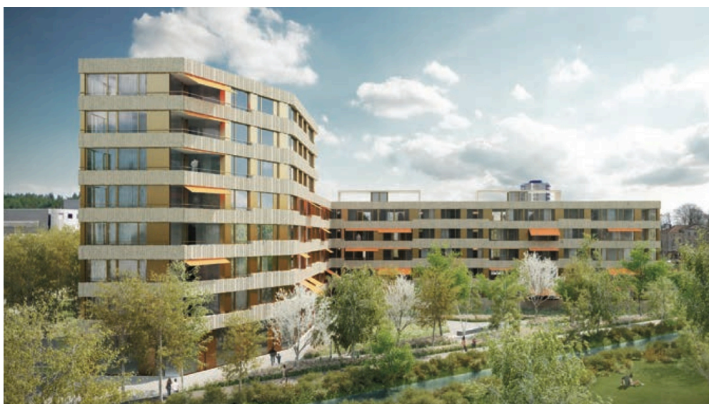
Figure 3 : Immeuble « Quattro A » (Source : KISTLER VOGT ARCHITEKTEN 2012a)
