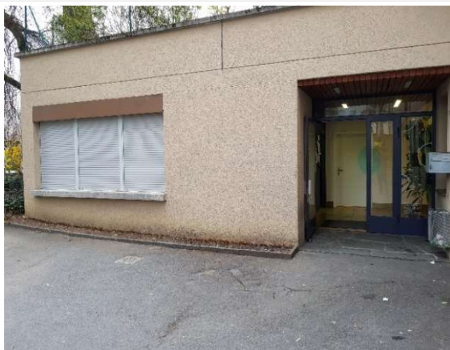
FIGURE I Porte vitrée d'entrée au Centre et grande fenêtre du bureau
