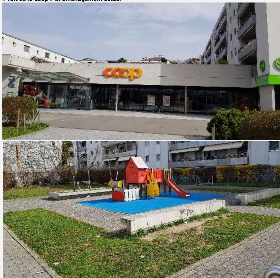
FIGURES h « Toit de la Coop » et aménagement actuel
