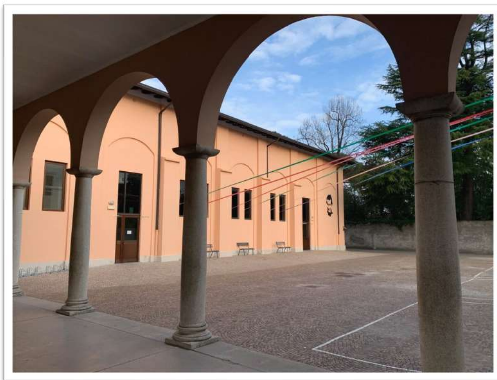
Figura 4.26 – Oratorio, squarcio del porticato, cortile e facciata principale
