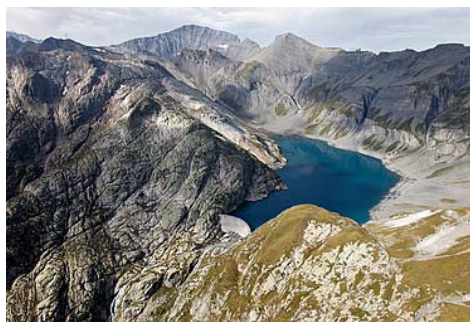
Figure 26. Barrage du Vieux-Emosson. Source: www.nant-de-drance.ch
