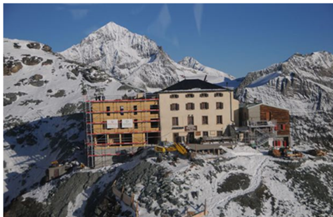
Figure 55. La cabane du Hörnli en travaux en 2014. A gauche, l'extension en construction et à droite la cabane du Hörnli et l'auberge du Belvédère. Source : Walliser Bote., www.1815.ch .
