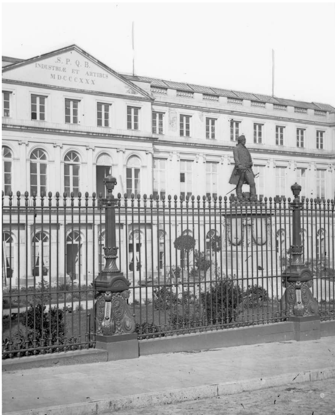
III. 7. Façade du Palais de l'industrie de Bruxelles. Anonyme, avant 1880.
