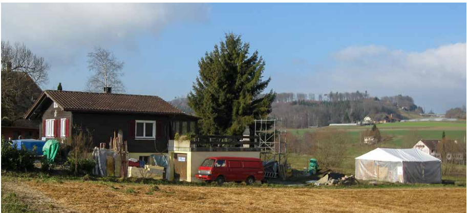
An- und Umbauten von bestehenden Gebäuden sind baubewilligungspflichtig und ausserhalb der Bauzonen nur beschränkt bewilligungsfähig. Ohne Baubewilligung gibt's früher oder später Ärger. Baubewilligungspflichtig sind auch provisorische Bauten, wenn sie mehr als drei Monate in der Landschaft stehen. Foto: L. Bühlmann, VLP-ASPAN
