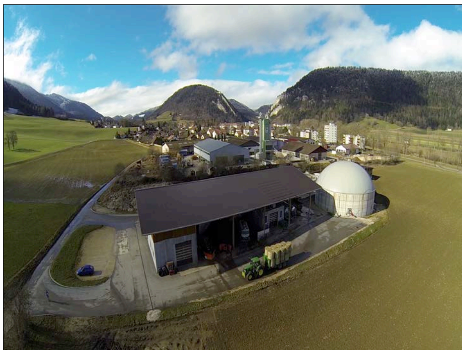
Figure 17 : Vue d'ensemble d'une installation de méthanisation et de chauffage à distance, Val-de-Travers. Photo de Simon Eschler.
