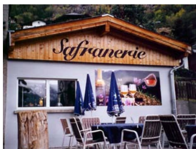
Figure 46 : façade de la Safranerie et terrasse du restaurant Safran
