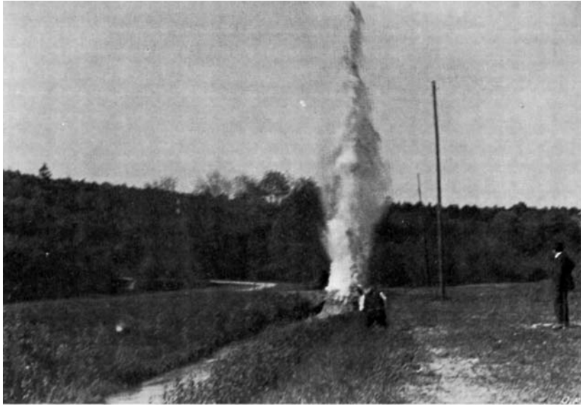
Auf der Allmend. Die in Zürich gefundenen Bomben werden zur Explosion gebracht. Die Fontaine bei Sprengung unter Wasser. Phot. F. Nünlist. Kant. Volkzeit-Photograph.
