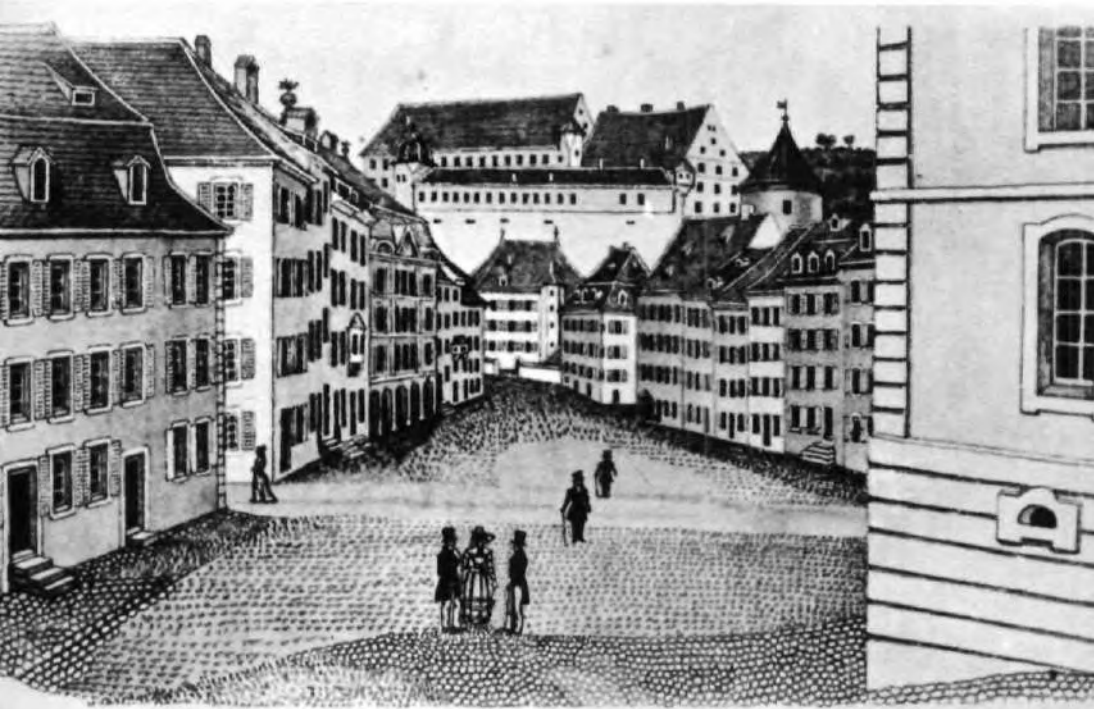
Porrentruy, la Grand-Rue avec le château
