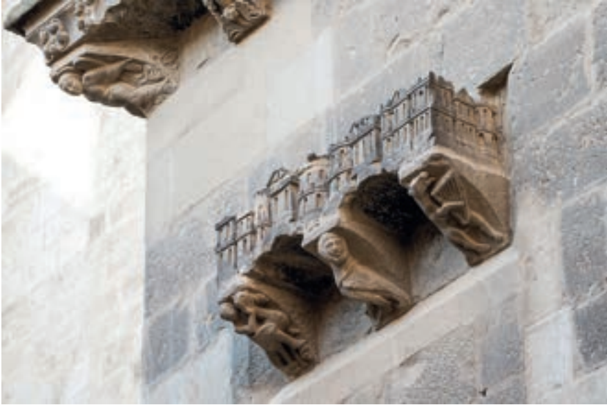
Figure 4. Tudela, cathédrale, façade occidentale, encorbellement à gauche du portail, Jérusalem céleste. (Photo : Blanca Aldanondo)
