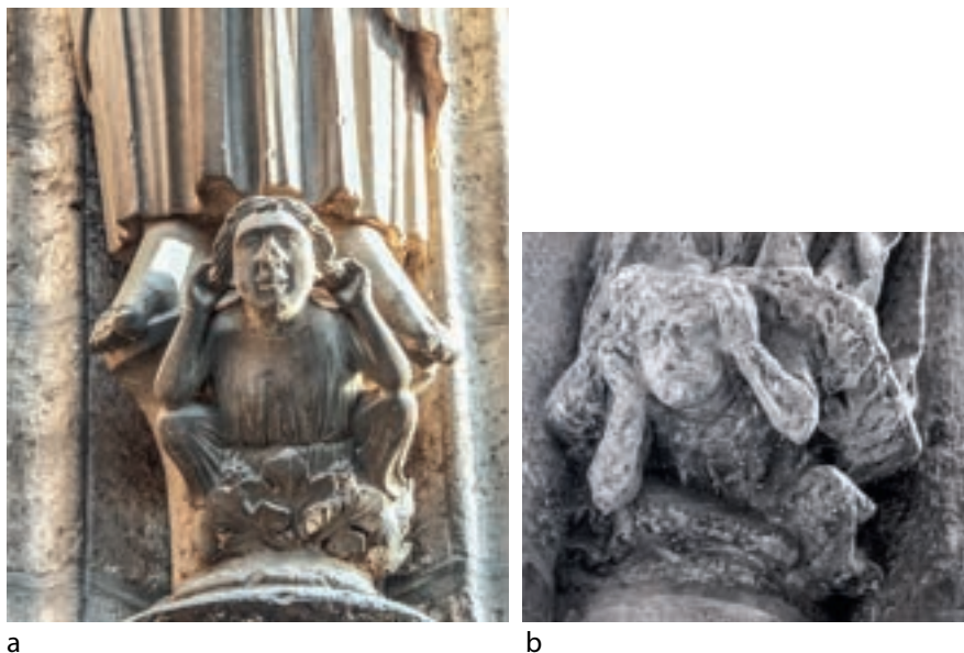
Figure 12. a) Chartres, cathédrale, montant droit du portail central du bras sud du transept, détail du piédestal de la statue-colonne; b) León, cathédrale, porche de la façade occidentale, deuxième pilier, statue nord-est, détail du piédestal. (© MedFrameS – Laurence Terrier et Laura Acosta)
