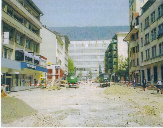
Fig. 7 : La place du Marché durant les travaux. Source: Haupt 2012
