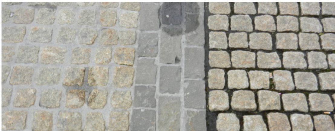
Fig. 21 : Détail des jointures. À gauche les joints sont comblés pour la portion qui traverse la Solothurnstrasse. À droite, les jointures sont creuses, pour le reste de ce passage piéton (cliché de l'auteur).
