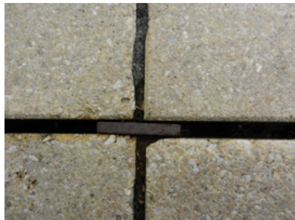
Fig. 13 : détail de l'agencement des dalles de béton teintés.
