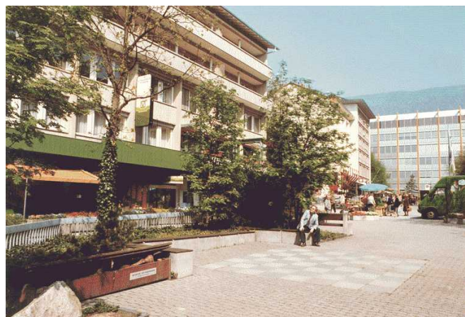
Fig. 5: Partie Sud de la place du marché, déjà piétonne avant les travaux. Source : Ville de Granges
