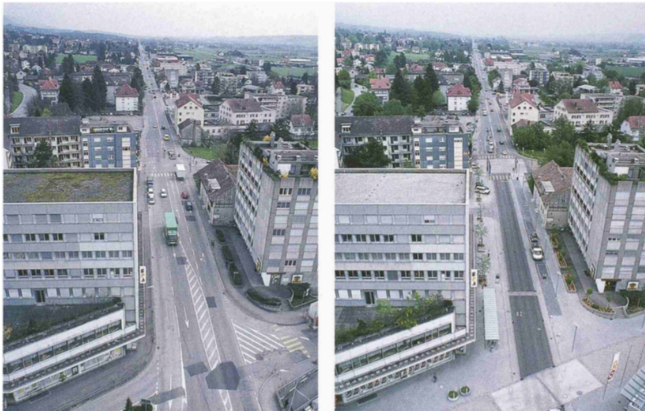
Fig. 18 : prise de vue aérienne permettant de visualiser la réduction de la largeur de la Solothurnstrasse par un jeu de revêtement. Source : Ville de Granges
