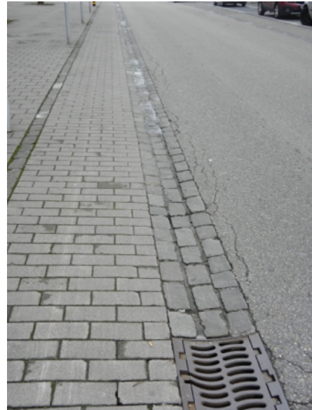
Figure 17: Détail de la bande pavée qui permet de réduire visuellement la largeur de la Solothurnstrasse (cliché de l'auteur)
