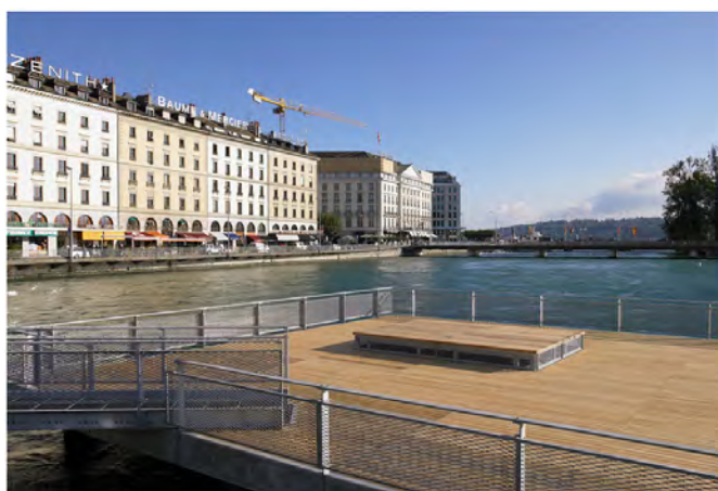
Figure 14 : La plateforme du pont de la Machine 133
