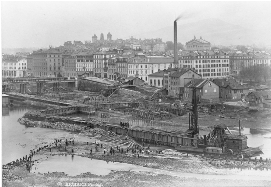
Figure 22 : Travaux d’approfondissement du Rhône et construction du bâtiment des forces motrices, 1883-1885 90
