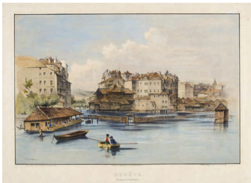
Figure 20 : La machine hydraulique (en bois au centre) en 1837 85
