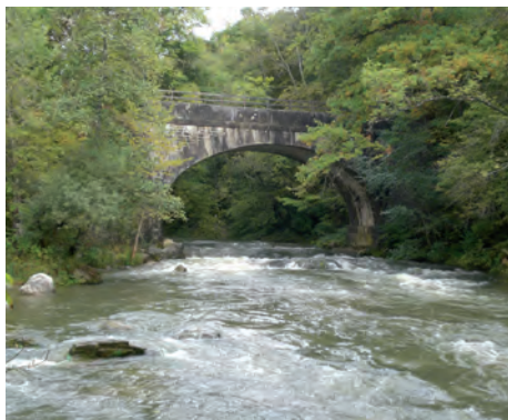
Le pont des Granges sur l'Allondon (GE)
