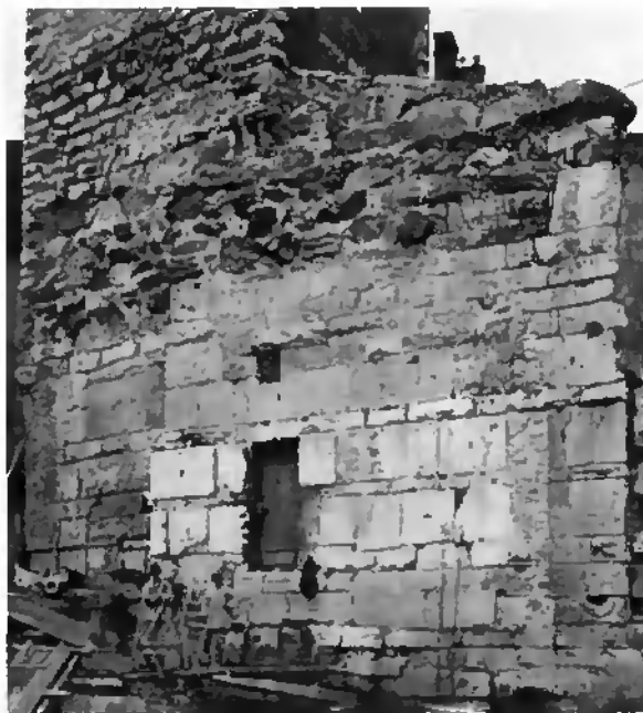
FIG. 53. — Base de la tour des Prisons (Neuchâtel), montrant l'utilisation des matériaux de construction romains.
