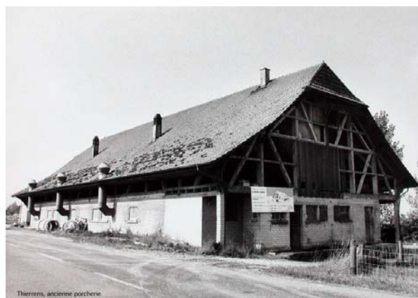
Fig. 132 Ancienne porcherie de Thierrens à la sortie est du village, transformée récemment en maison locative.
