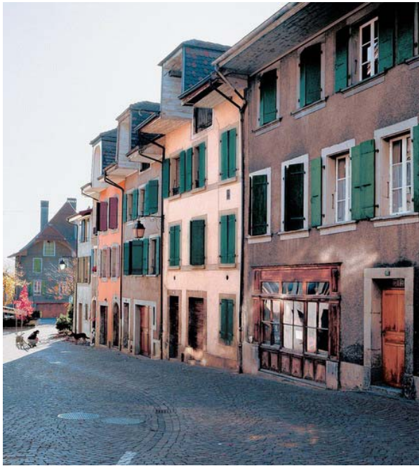
Fig. 72 Maisons vigneronnes accolées à dômes au Voisinand sur la commune de Lutry.
