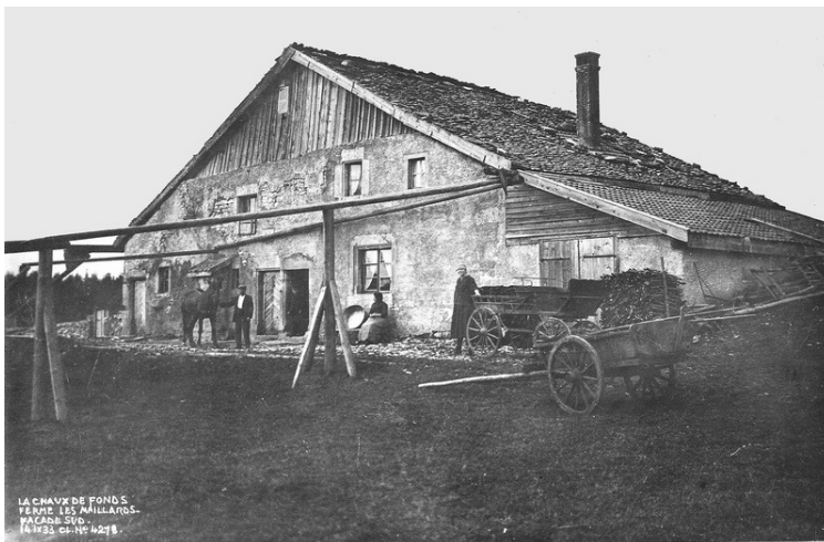
Fig. 81 Ferme à pignon frontal aux Maillard sur le territoire de La Chaux-de-Fonds. Photo de 1933, coll. Office de la protection des monuments et des sites. Façade sud-est.
