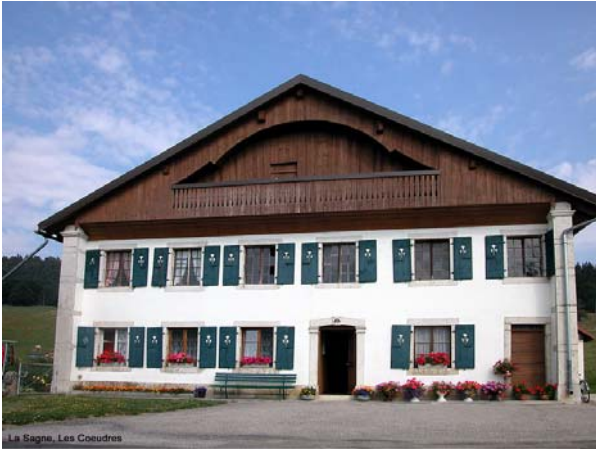
Fig. 103 Ferme à pignon frontal aux Coeudres à La Sagne, façade sud-est comprenant deux niveaux, une ramée-larmier en encorbellement avec galerie, fin XVIII e siècle.
