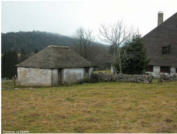
Fig. 120 Boiton couvert en tavillons dissocié du chalet. La Redalle sur la commune de Provence.
