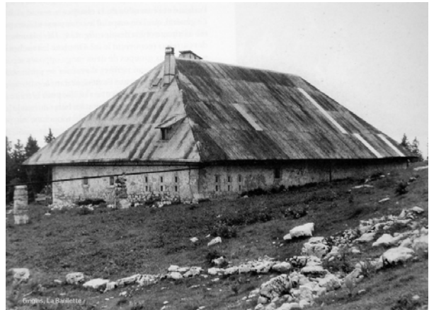
Fig. 114 Chalet de La Barillette sur la commune de Gingins. Les larmiers de la chambre à lait sont bien visibles autour de l'angle nord.
