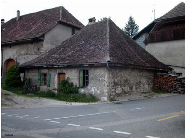
Fig. 126 Fromagerie coiffée d'une toiture à quatre pans imitant celles des chalets d'alpage, dans le village de Rances près d'Orbe au pied du Jura.
