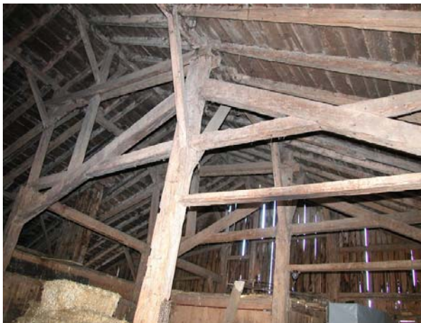
Fig. 102 Surélévation de charpente à La Montagne-de-Buttes.
