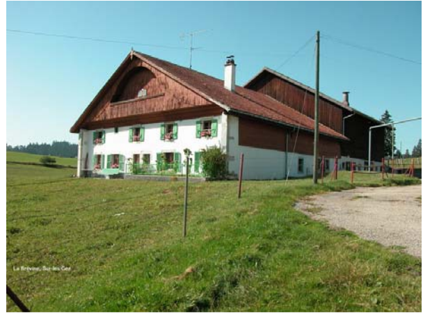
Fig. 104 Ferme à pignon frontal à Sur-les-Gez (c. de La Brévine) avec agrandissement sur l'arrière. Façades sud-est et nord-est.
