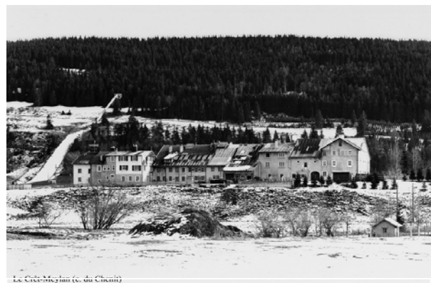
Fig. 79 Voisinage du Cret-Meylan sur la commune du Chenit. Façade nord-ouest. Les bâtiments ont été surélevés et adaptés aux besoins générés par le développement industriel
