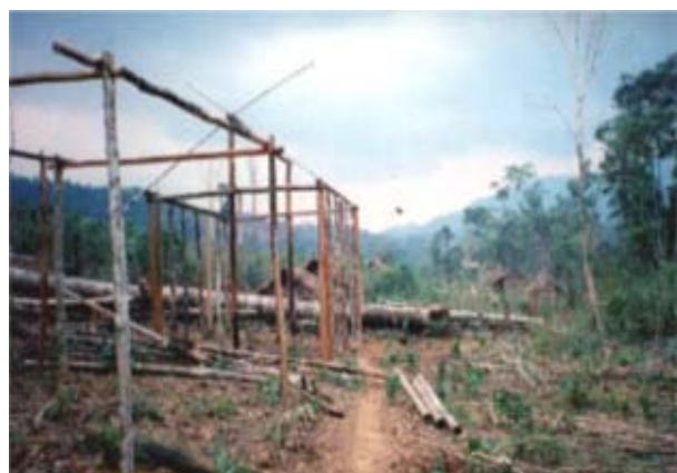
Photo 11: Construction d'un nouveau village, versant Ouest
