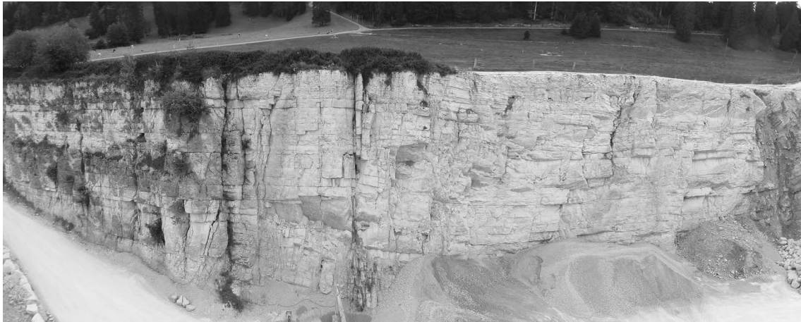
FIGURE C.2 – Photos du mur Sud de la carrière des Breuleux, correspondant au profil principal P1 .
