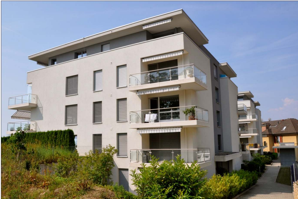
28 appartements dont les deux tiers sont en propriété Photo de l'auteur, 2010
