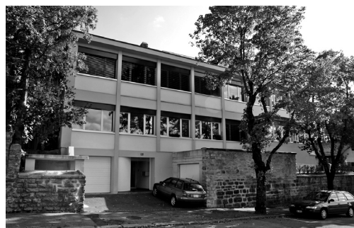
Photo 4. Ancienne manufacture horlogère (13 logements).
