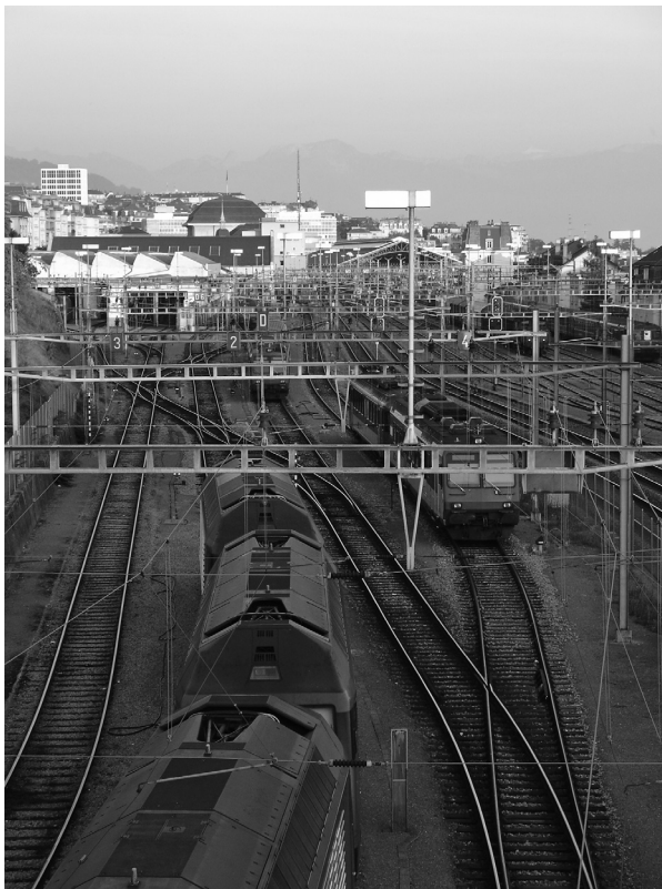
Photo 3 : Lausanne, atelier des locomotives, 2007
