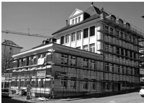
Photo 5. Ancienne manufacture horlogère (10 logements et 2 bureaux).
