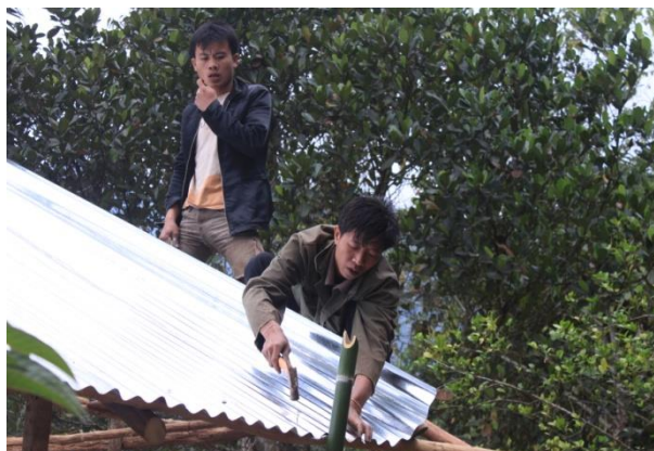
Figure 4.45 La pose des tôles. On voit, devant les tôles, le bambou qui a permis son maintien par le dessous
