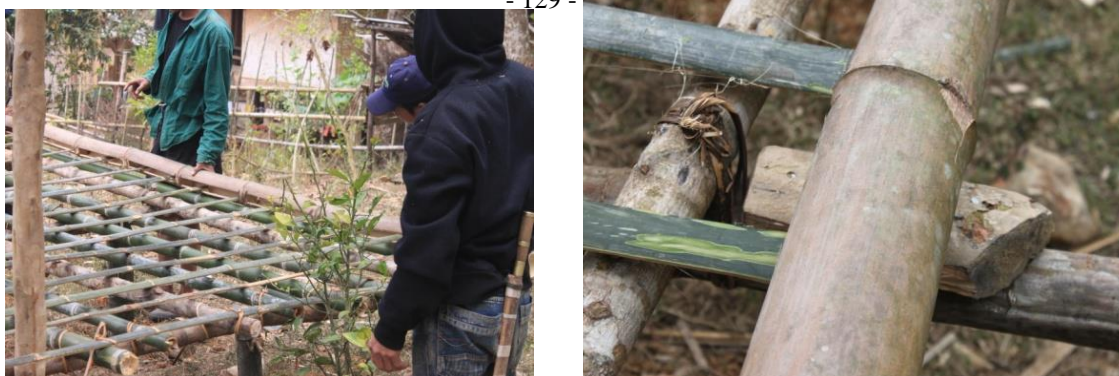
Figure 4.26 Les lambourdes sont fixées à leurs extrémités par un bambou. On peut voir, sous les lambourdes, l'alternance entre les solives en bambou et les solives en bois.
