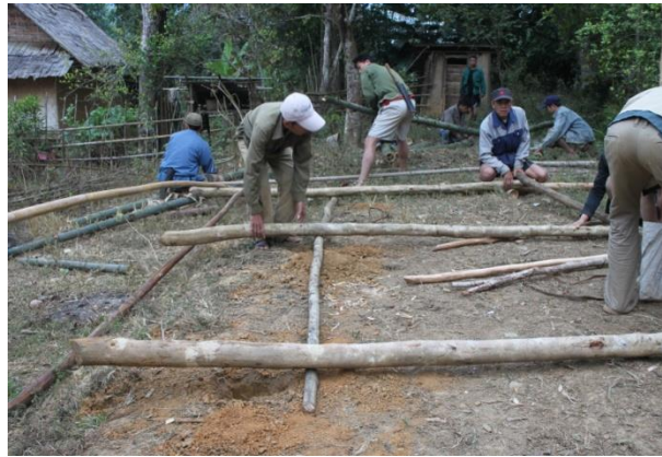
Figure 4. 4 Les poteaux sont posés au sol de manière perpendiculaire au trois premiers trous. La poutre du toit est fixée avant que les poteaux soient levés
