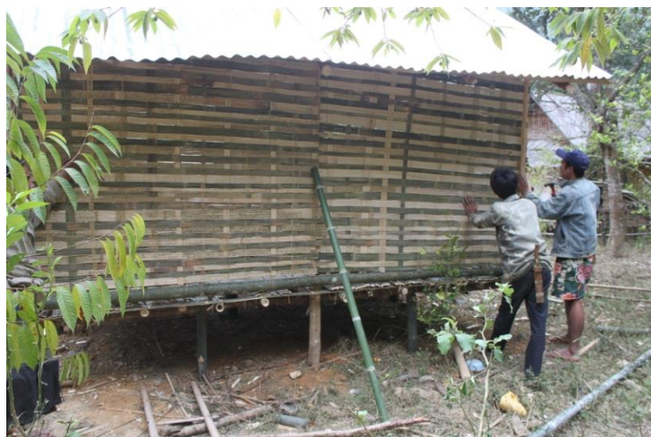
Figure 4.54 Les panneaux sont placés puis cloués avec une tige de bois qui est posée sur les panneaux. Il ne reste plus que cinq personnes à l'ouvrage
