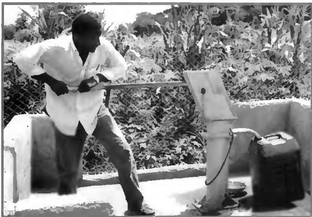
Planche XV: Système d'exhaure manuelle servant à l'approvisionnement du village de Koumbougo en eau potable
