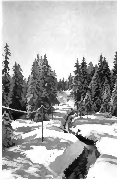
Fig. 6. Canal de la scierie, vu du barrage. Le fil de fer commande la vance.
