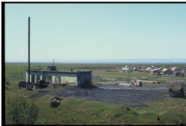
Photo 5 : Centrale de chauffage désaffectée dans un village du DAK (Plattet, 2002).
